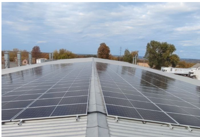
Черкаська область, станція потужністю 179,82 кВт, Розведення свійської птиці
